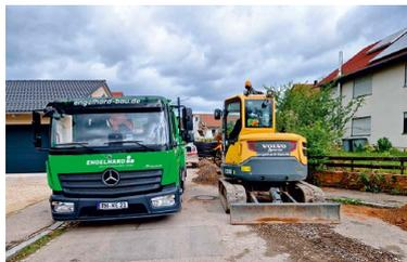
Das Nahwärmenetz läuft planmäßig. Bauabschnitt 1 im Bereich Zellgasse schreitet Meter um Meter voran. Die Baumaßnahmen sind im Zeitplan. Die Firma Engelhard verlegt die Leitungen auf 11 Kilometer Länge.
