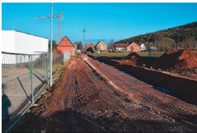
Die Erschließung mit der Kanaltrasse mit dem Oberflächenwasserkanal sowie Nahwärmenetz und Leerrohre für den Glasfaserausbau im Jahre 2024 wird derzeit durchgeführt. Zusätzlich wird ein Rückhaltebauwerk errichtet, um eine
